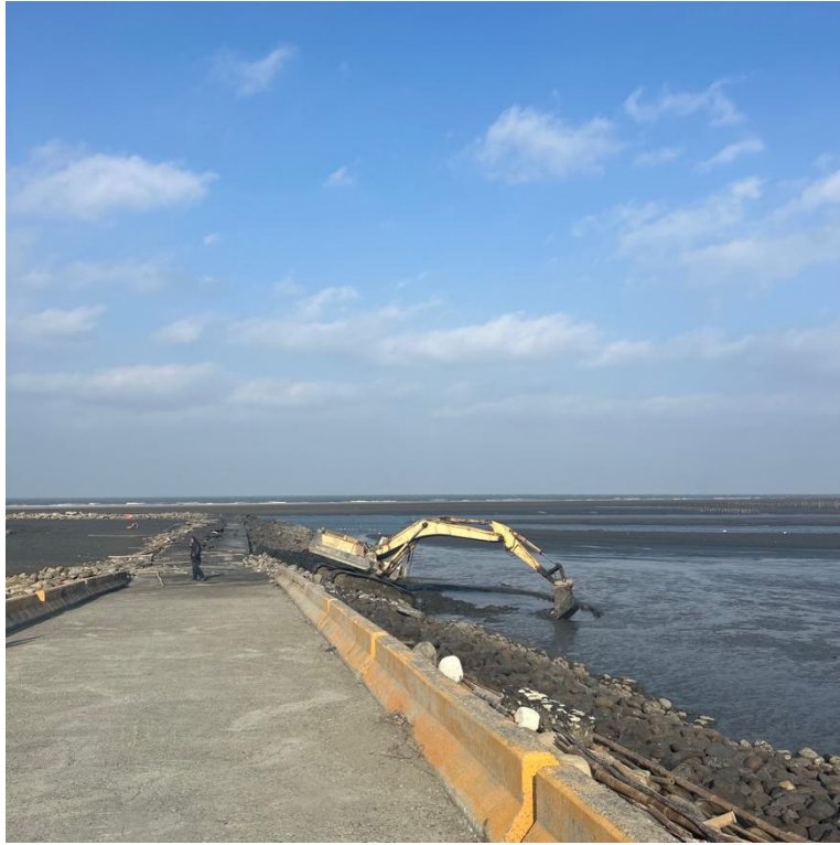
圖十二 四湖鄉林厝寮大排旁堤岸復建工程
