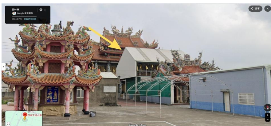
圖三十五 正殿上架設的保護鋼棚
