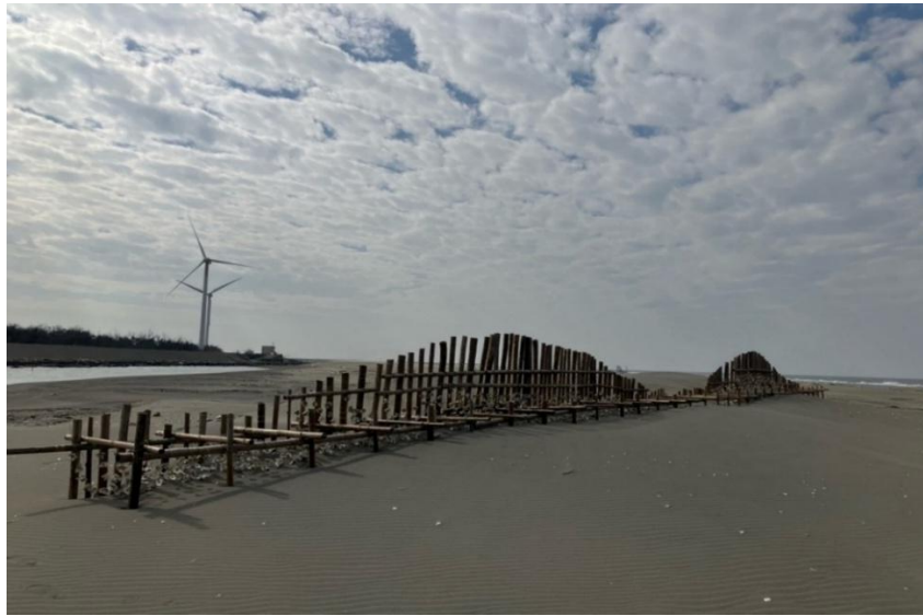
圖三，成大水工所於 2024 年下旬與當地人合作築起的固沙裝置 (作者於田野期間自攝)
