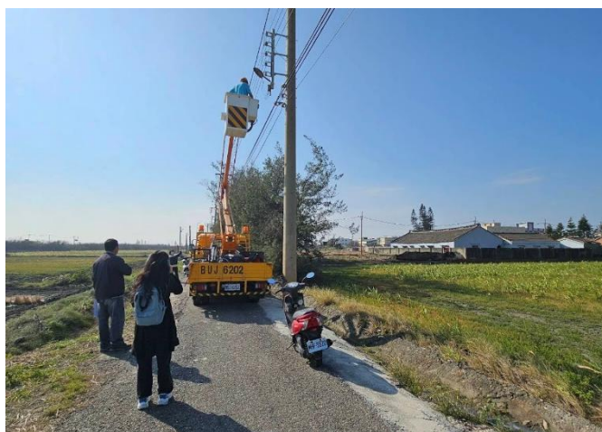
圖十一、維修現場。 (資料來源：組員依婕於 2025/1/7 拍攝。)
